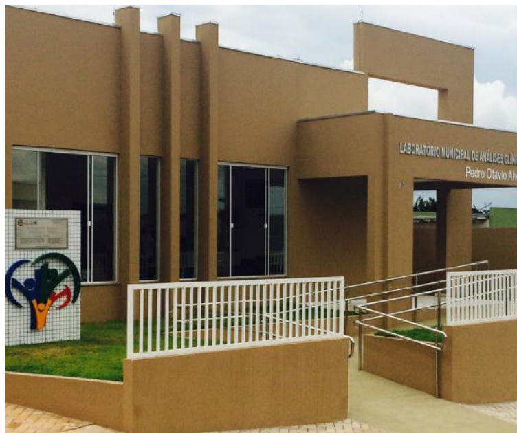
Figura 29: Construção Laboratório de Análises Clínicas.
