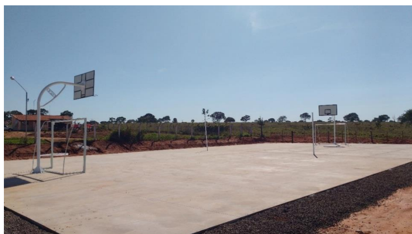
Figura 30: Construção Quadra Poliesportiva.
