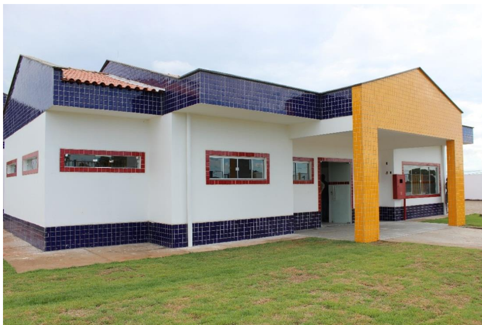
Figura 33: Construção de CEI.
