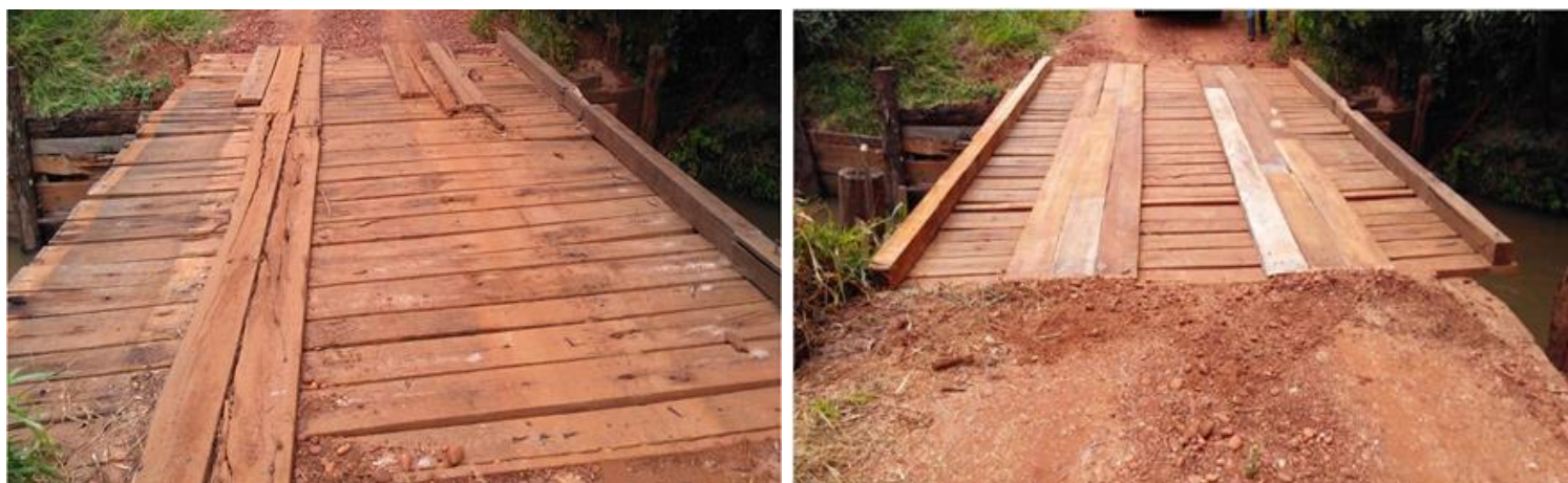
Figura 17: Reforma de ponte – Fazenda Rancharia.
