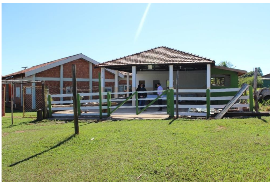
Figura 31: Reforma Centro Comunitário de Garcias.
