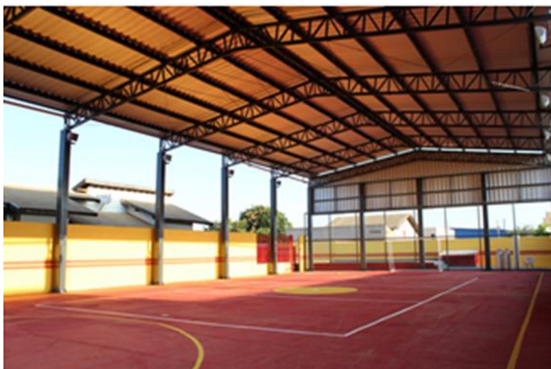
Figura 28: Cobertura Quadra de Bombeiros.
